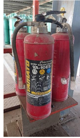
消火器 (ピンが外れている)
